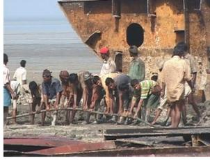
写真1 防護眼鏡をしないガス切断作業者 写真2 労働集約的に揚重する作業者
